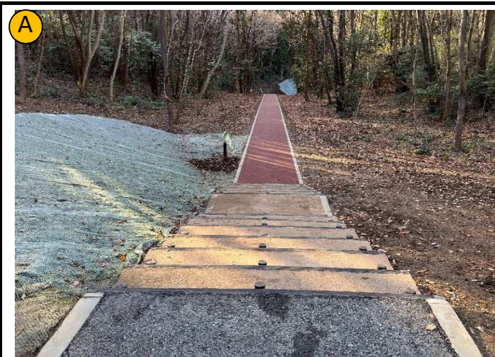
撮影日 | R4.12撮影 | 状況 | 完了 撮影箇所 | 廃タイヤ使用ゴムチップ舗装
