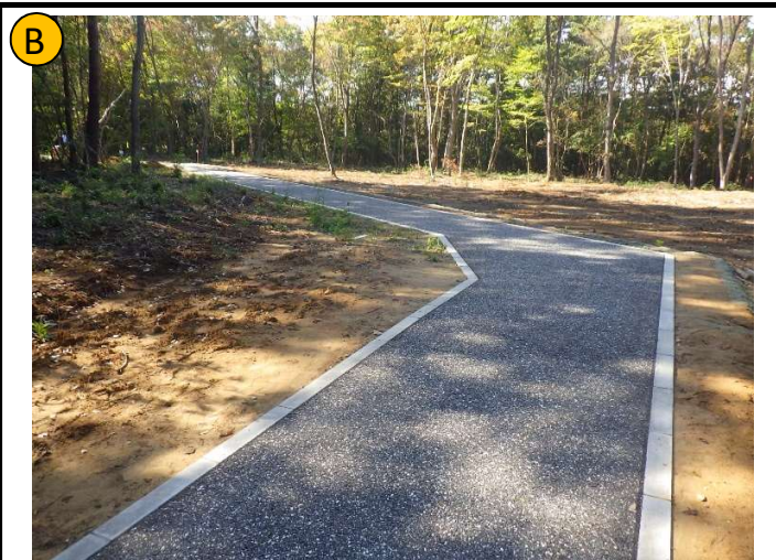
撮影日 | R4.10撮影 | 状況 | 舗装完了 撮影箇所 | 貝殻入りアスファルト舗装
