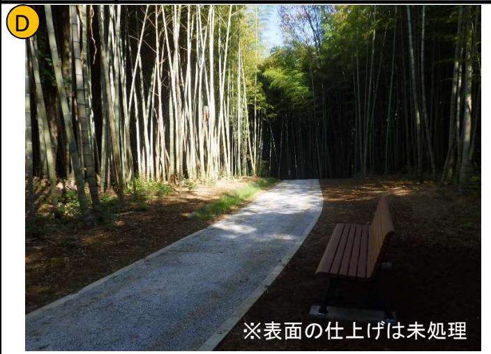
撮影日 | R4.10撮影 | 状況 | 舗装完了 撮影箇所 | 透水性瓦コンクリート舗装
