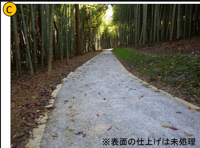
撮影日 | R4.10撮影 | 状況 | 舗装完了 撮影箇所 | 透水性瓦コンクリート舗装
