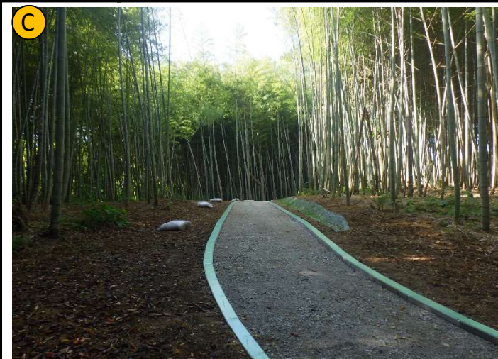
撮影日 | R4.9撮影 | 状況 | 路盤完了 撮影箇所 | 透水性瓦コンクリート舗装
