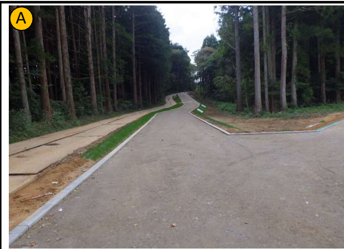
撮影日 | R4.9撮影 | 状況 | 路盤完了 撮影箇所 | セメント木質舗装
