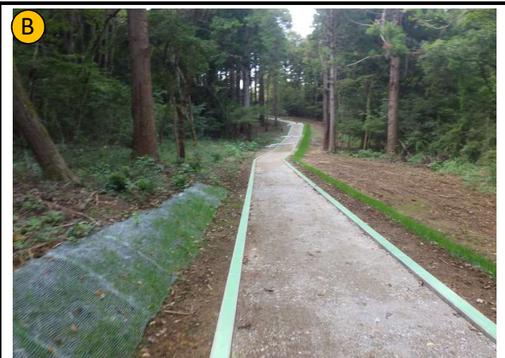
撮影日 | R4.9撮影 | 状況 | 路盤完了 撮影箇所 | 貝殻入りアスファルト舗装
