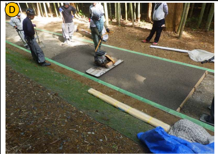
撮影日 | R4.10撮影 | 状況 | 舗装状況 撮影箇所 | 透水性瓦コンクリート舗装
