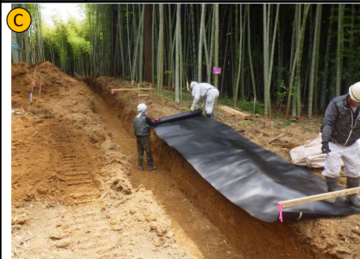
撮影日 R4.7撮影 状況 防根シート設置 撮影箇所 排水性瓦コンクリート舗装
