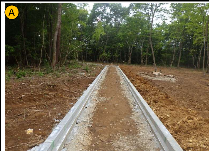
撮影日 R4.7撮影 状況 地先境界ブロック設置 撮影箇所 貝殻入りアスファルト舗装
