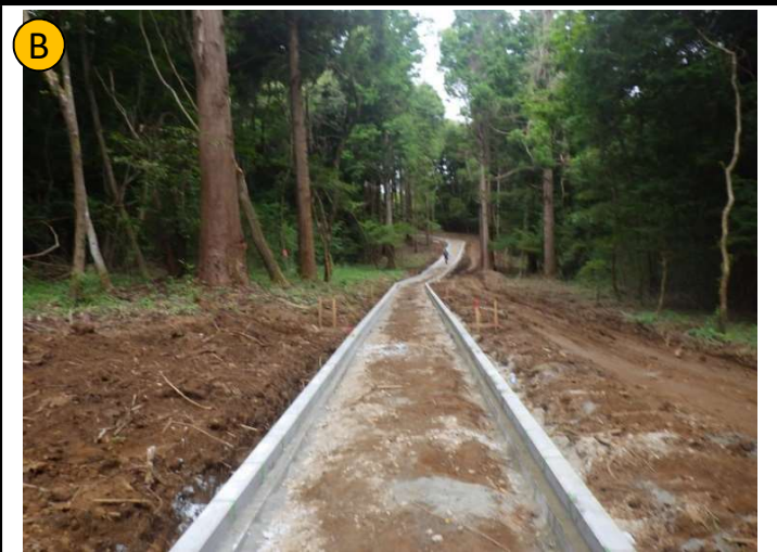
撮影日 R4.7撮影 状況 地先境界ブロック設置 撮影箇所 貝殻入りアスファルト舗装
