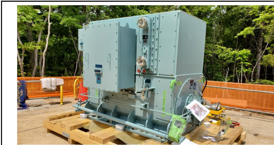
No.65 令和4年5月撮影 工事種別 プラント設備 状況 焼却施設（タービン発電機搬入）
