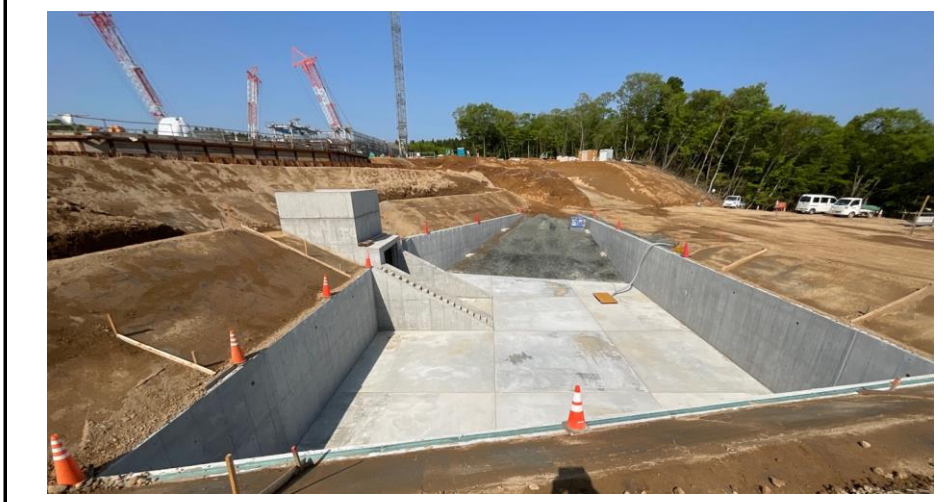
No.67 令和4年5月撮影 工事種別 外構工事 状況 調整池工事（築堤工事）
