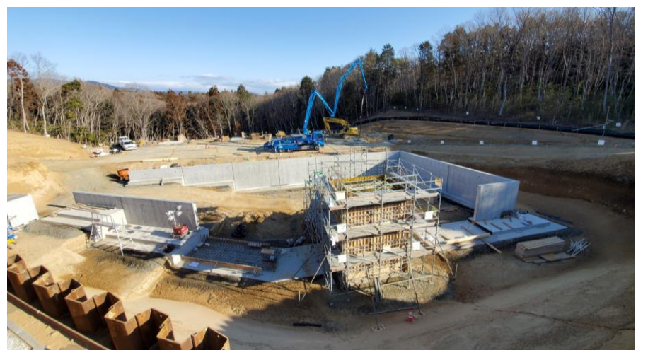
No.48 令和4年2月撮影 工事種別 外構工事 状況 調整池工事（擁壁工事・排水塔コンクリート工事）
