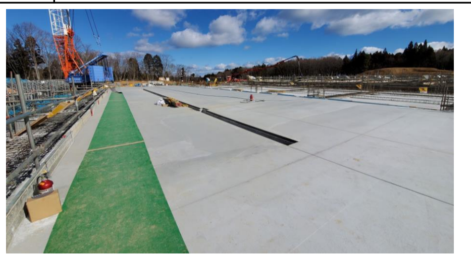
No.48 令和4年2月撮影 工事種別 基礎・土間工事
