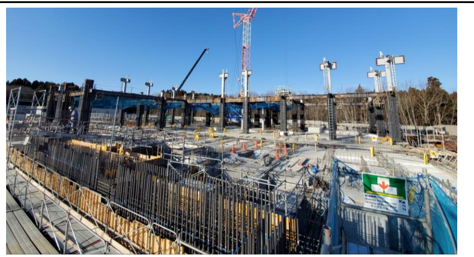
No.46 令和4年2月撮影 工事種別 鉄骨工事
