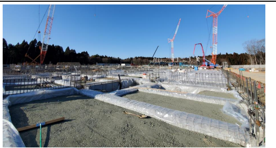
No.46 令和4年2月撮影 工事種別 基礎・土間工事 状況 リサイクル施設－基礎工事（基礎埋戻し・土間配筋工事）
