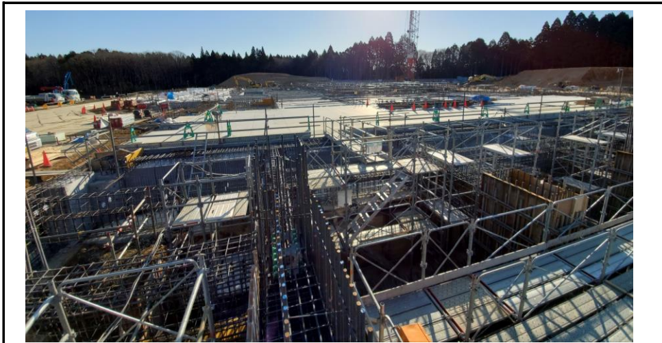
No.45 令和4年2月撮影 工事種別 基礎・土間工事 状況 焼却施設－基礎・土間工事（地下ごみピット壁コンクリート工事）
