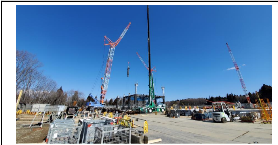
No.45 令和4年2月撮影 工事種別 基礎・土間・鉄骨工事
