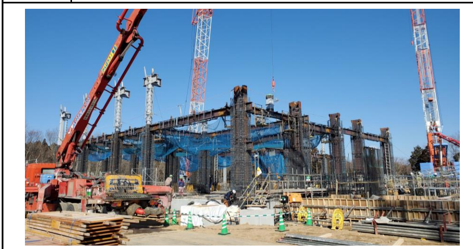
No.47 令和4年2月撮影 工事種別 鉄骨工事
