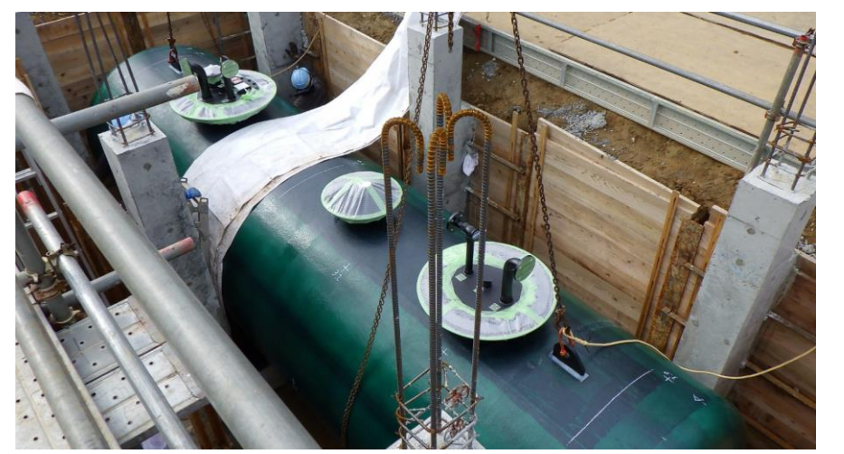
No.28 令和3年11月撮影 工事種別 設備工事 状況 燃料貯留槽設置工事(15,000L)
