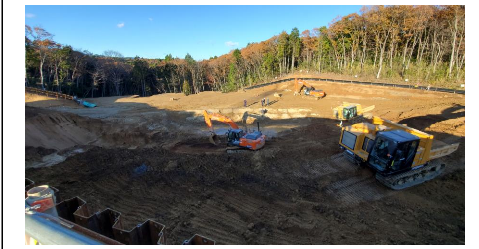
No.27 令和3年11月撮影 工事種別 外構工事 状況 調整池工事(盛土・安定処理工)
