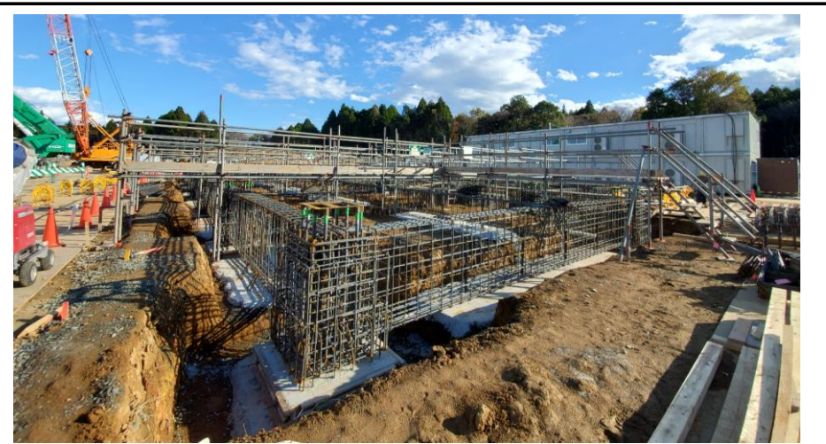
No.26 令和3年11月撮影 工事種別 基礎工事 状況 管理棟-基礎工事(基礎配筋・コンクリート工事)
