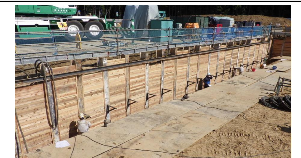
No.10 令和3年7月撮影 工事種別 地業・基礎・土工事 状況 山留工事（地盤を掘削する際に周辺が崩れないための保護工事）
