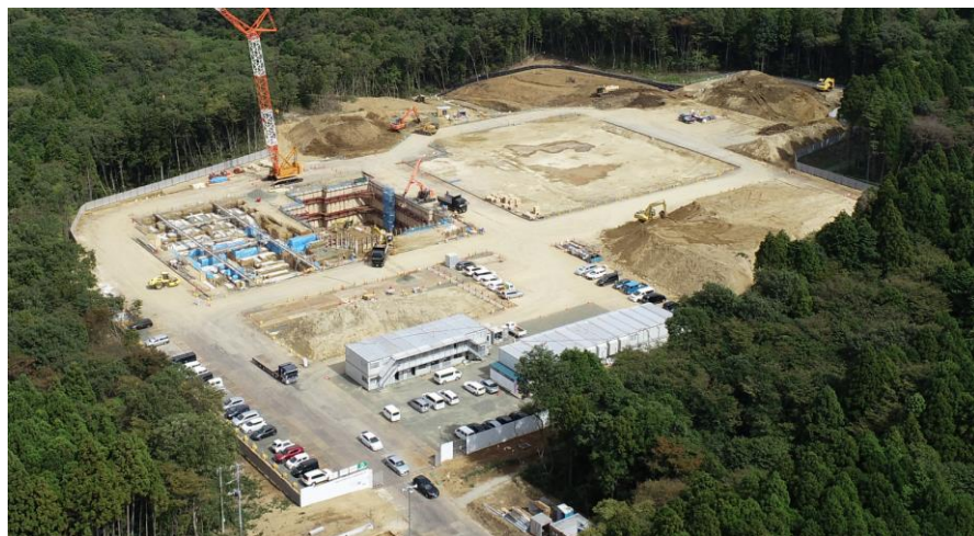
No.13 令和3年9月撮影(敷地南西側から) 工事種別 地業・基礎・土工事
