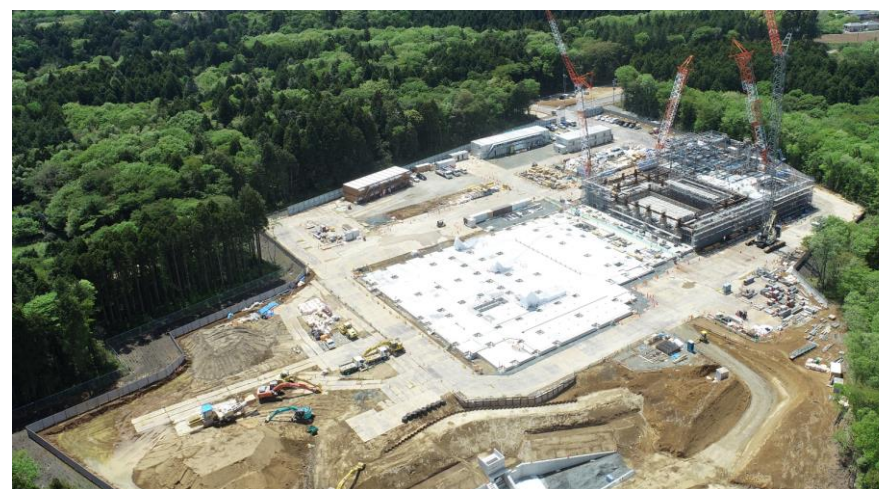
No.28 令和4年4月撮影(敷地北東側から) 工事種別 鉄骨工事・コンクリート工事
