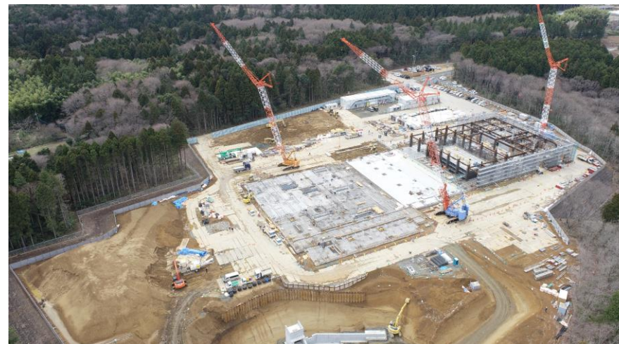
No.26 令和4年3月撮影(敷地北東側から) 工事種別 鉄骨工事・基礎コンクリート工事
