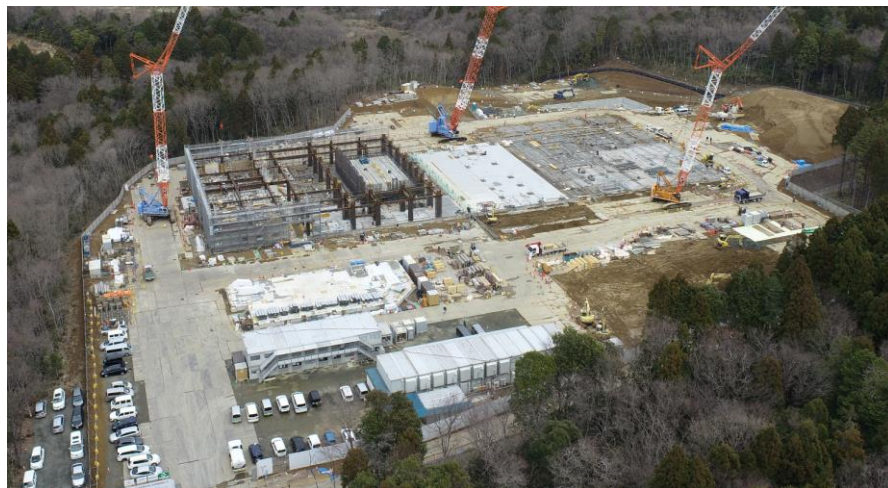
No.25 令和4年3月撮影(敷地南西側から) 工事種別 鉄骨工事・基礎コンクリート工事
