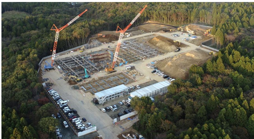
No.15 令和3年10月撮影(敷地南西側から) 工事種別 地業・基礎・土工事
