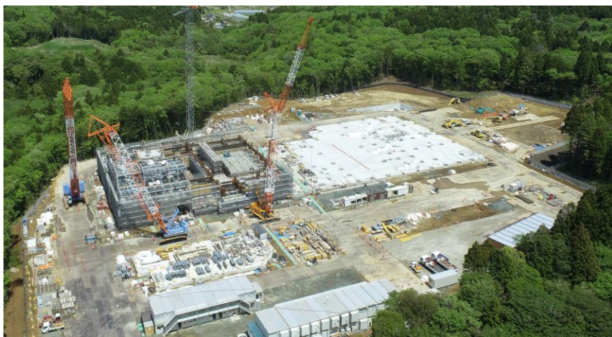
No.27 令和4年4月撮影(敷地南西側から) 工事種別 鉄骨工事・コンクリート工事
