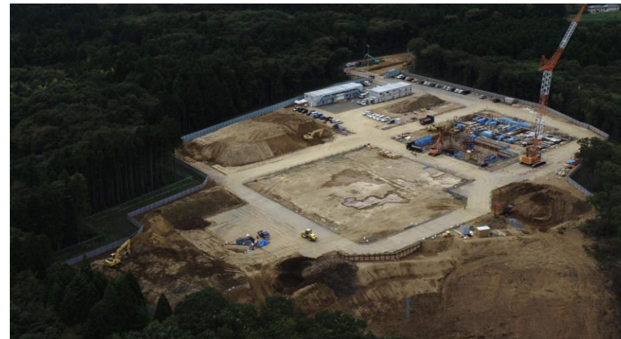
No.14 令和3年9月撮影(敷地北東側から) 工事種別 地業・基礎・土工事
