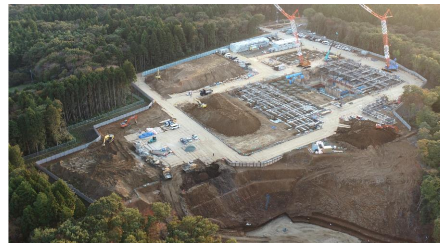
No.16 令和3年10月撮影(敷地北東側から) 工事種別 地業・基礎・土工事
